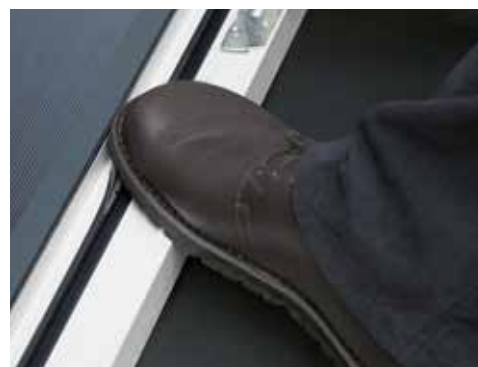
Uszczelka środkowa naklejona w profilu ramowym
