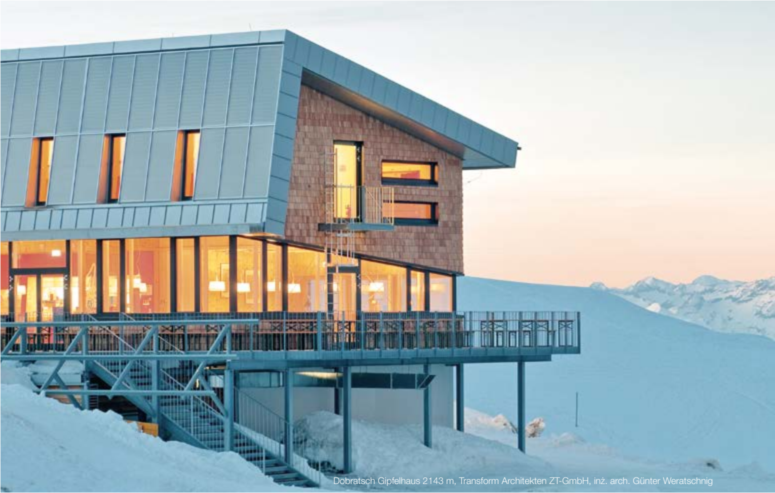
Dobratch Gipfelhaus 2143 m, Transform Architekten ZT-GmbH, inż. arch. Günter Weratschnig
